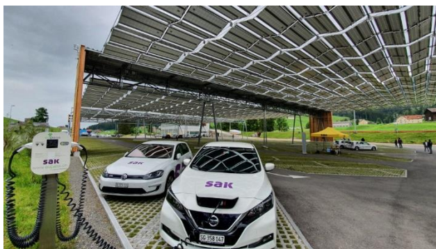
Beispiel einer faltbaren Solaranlage über einem Parkplatz in Jakobsbad-Kronberg (Appenzell Innerrhoden) 11
