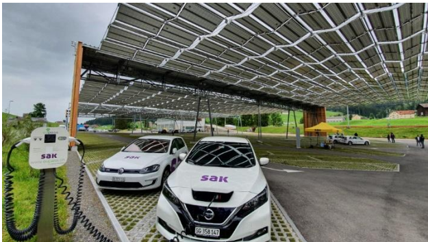
Beispiel einer faltbaren Solaranlage über einem Parkplatz in Jakobsbad-Kronberg (Appenzell Innerrhoden) 9
